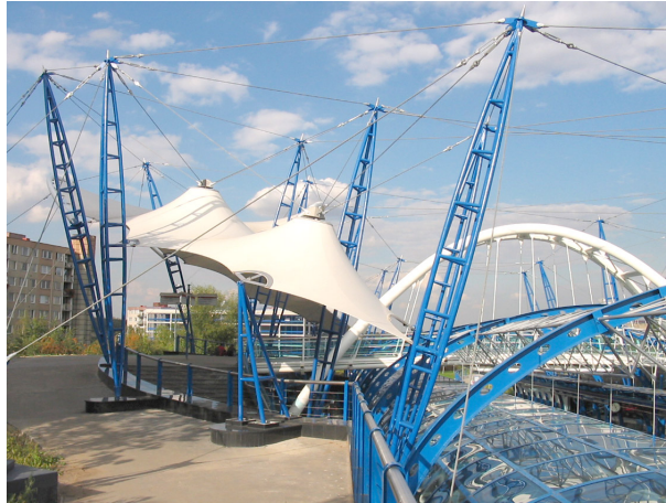
Obrázek 3.1: Tramvajová zastávka K Barrandovu, Praha
